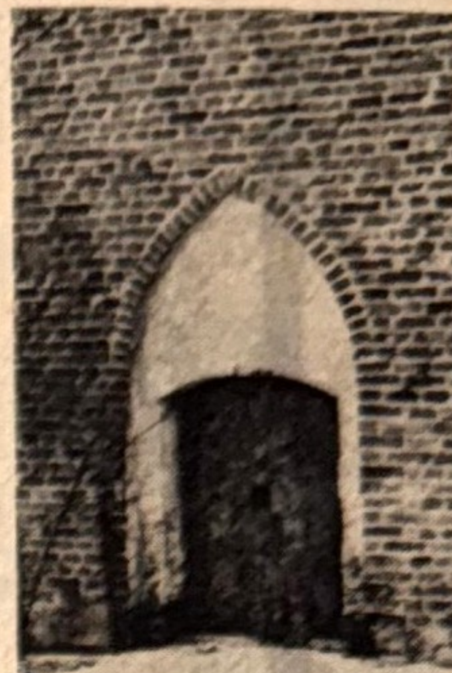
Een detailopname van de toren waarop de spitsbogige ingang is goed uitkomt. Op de foto is duidelijk te zien dat de deur, evenals de toren in een slechte staat van onderhoud verkeert.
