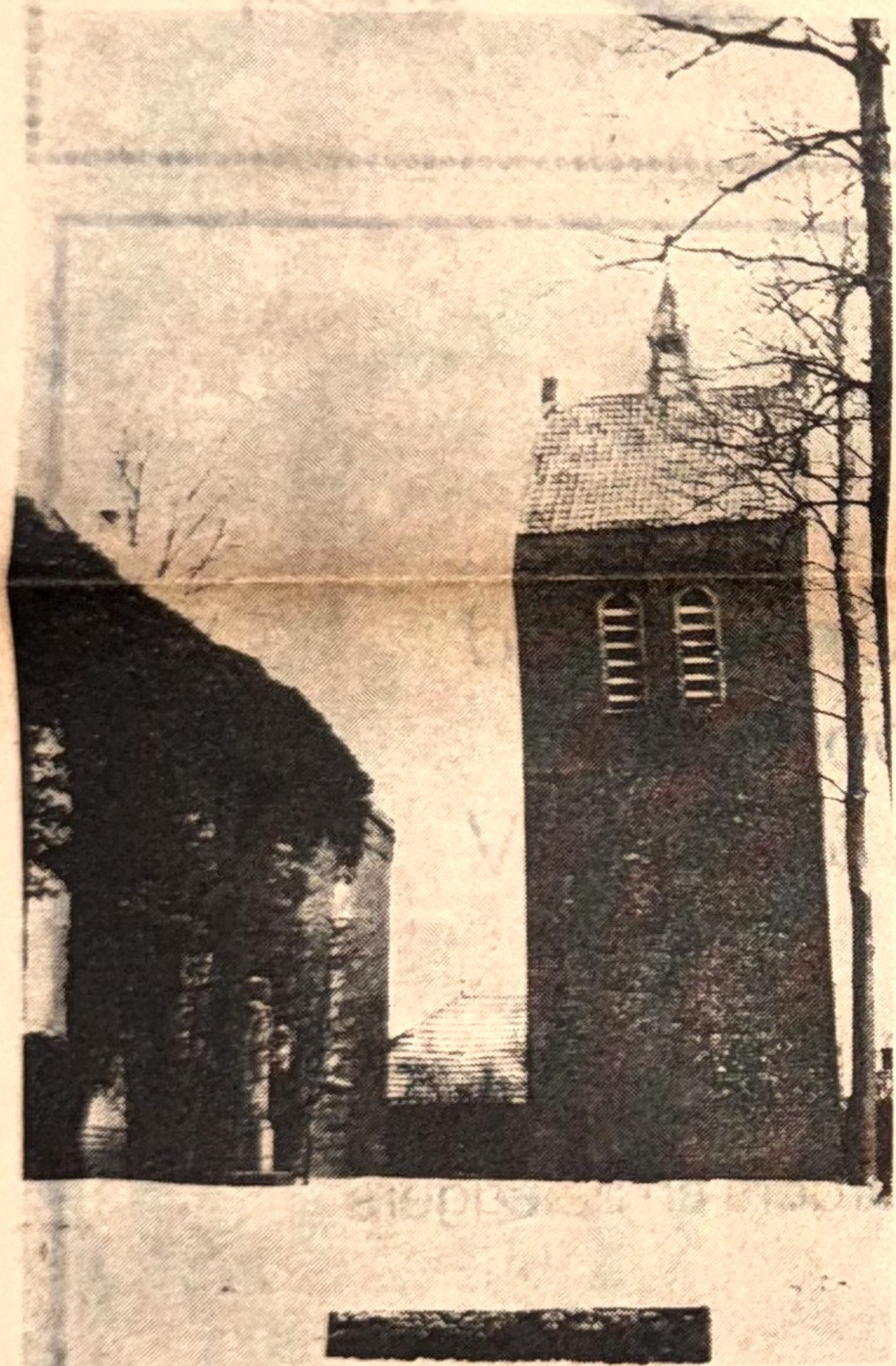
Een opname van de toren van Baflo die als een wachter dag in dag uit waakt over de aan zijn voet liggende huiscjes. Het los van de kerk staande bouwwerk verkeert in een niet al te beste staat en dient nodig eens onder handen te worden genomen. De muren van de kerk zijn op meerdere plaatsen begroeid met een dichte laag klimop. Het uiterlijk biedt niet veel fraais. Het beeldje naast de kerk herinnert aan de gevallen in de tweede wereldoorlog.
