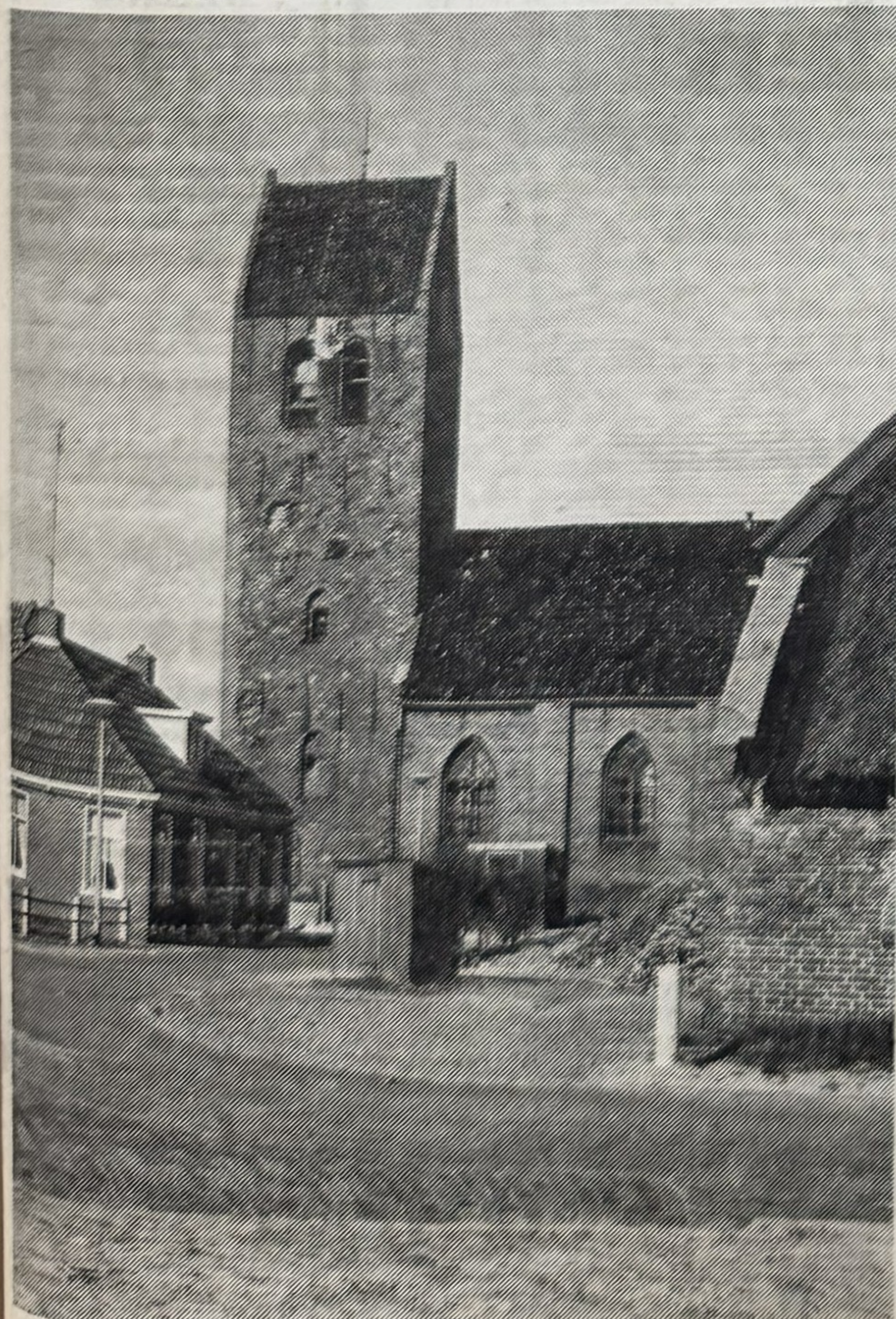
De Nederlandse Hervormde kerk te Kloosterburen. De toren is danig in verval geraakt. Een restauratie is dan ook hoogst urgent.
