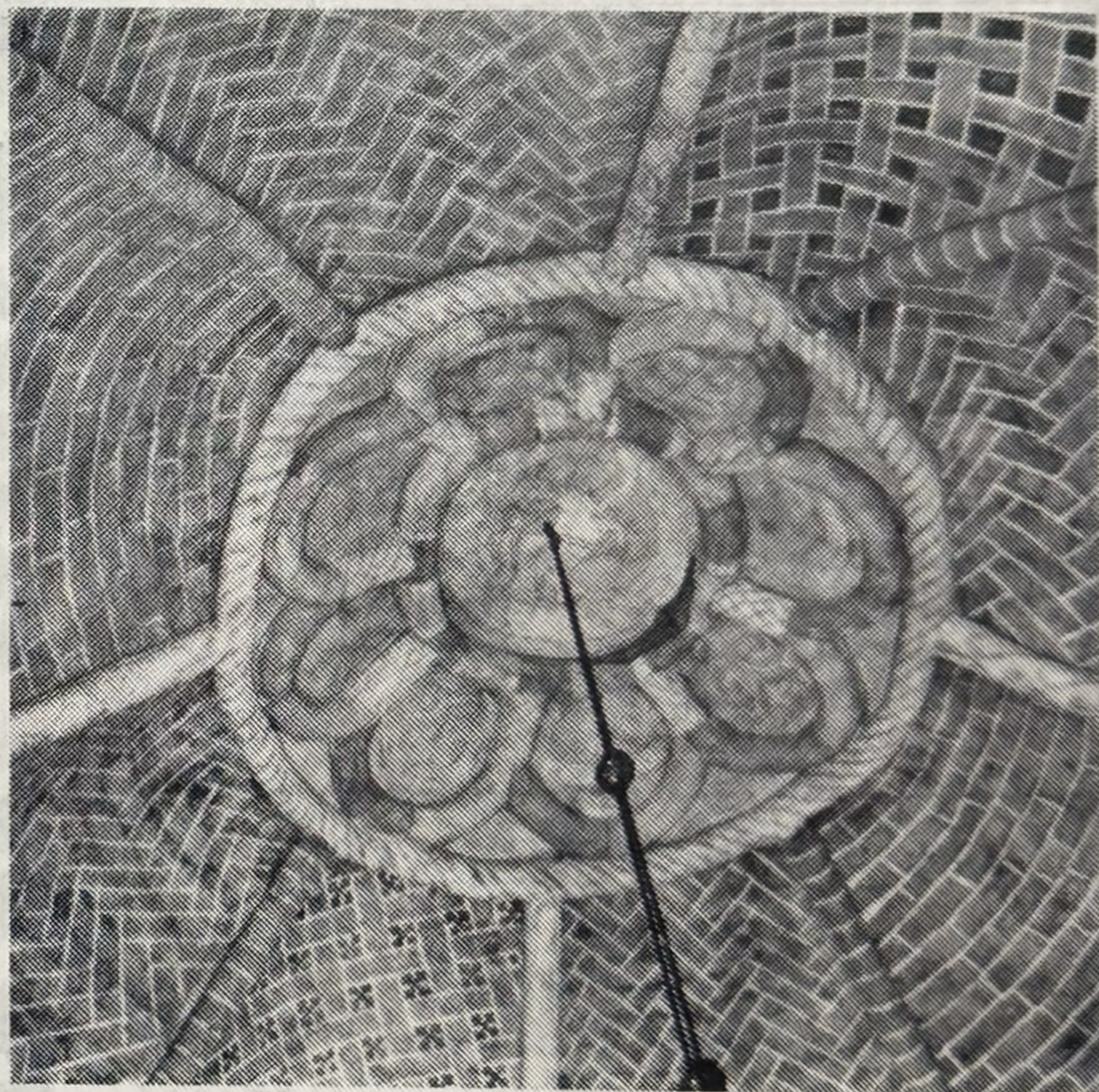
Het meloenvormig koepelgewelf van het koor: Duidelijk is de decoratieve bewerking te zien alsmede de 8 ronde ribben.
