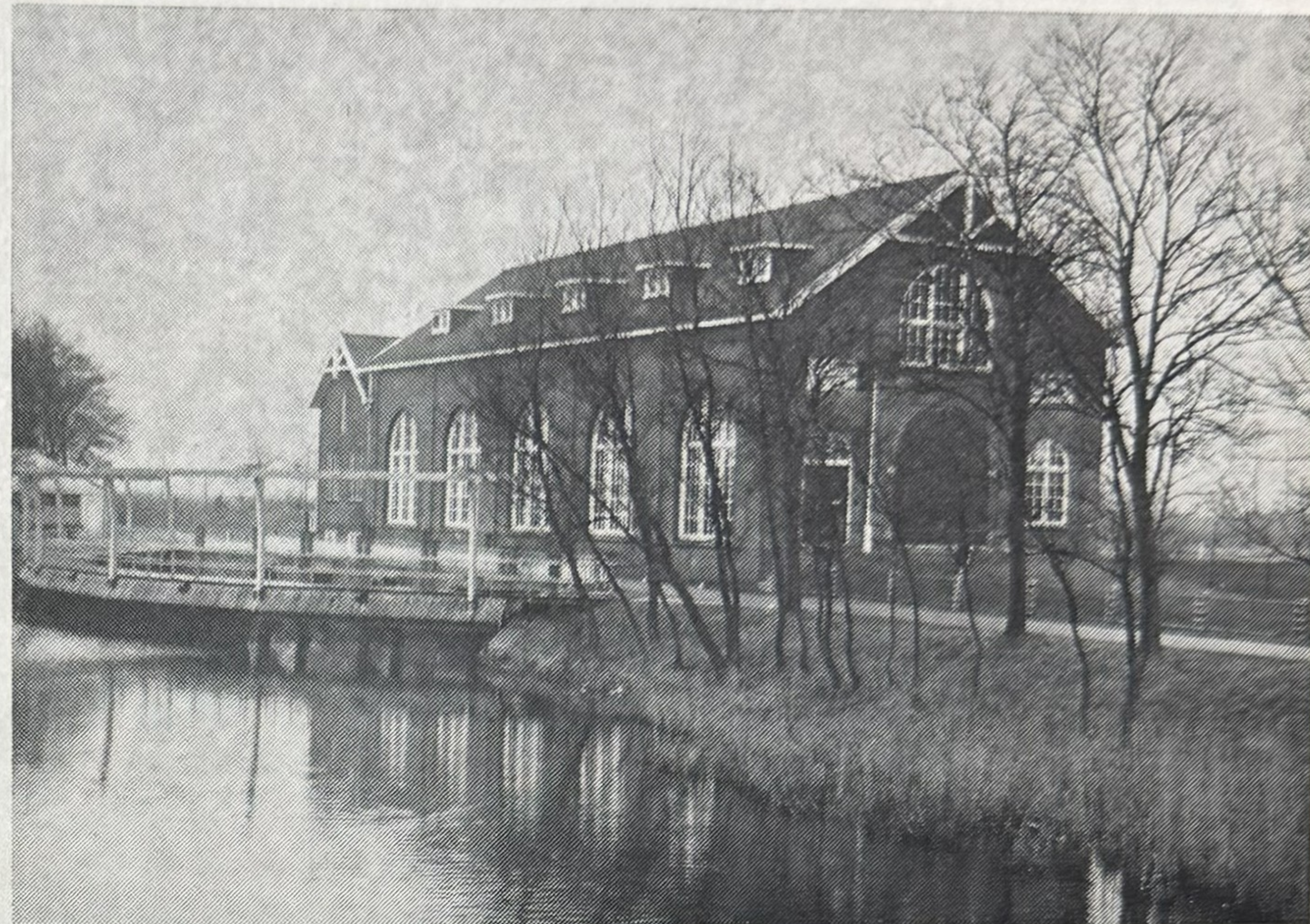
Het watergemaal „De Waterwolf” bij Lammerburen. Dit gemaal werd in het jaar 1920 door de koningin in werking gesteld. Het heeft een capaciteit van 4 miljoen liter water per minuut.
