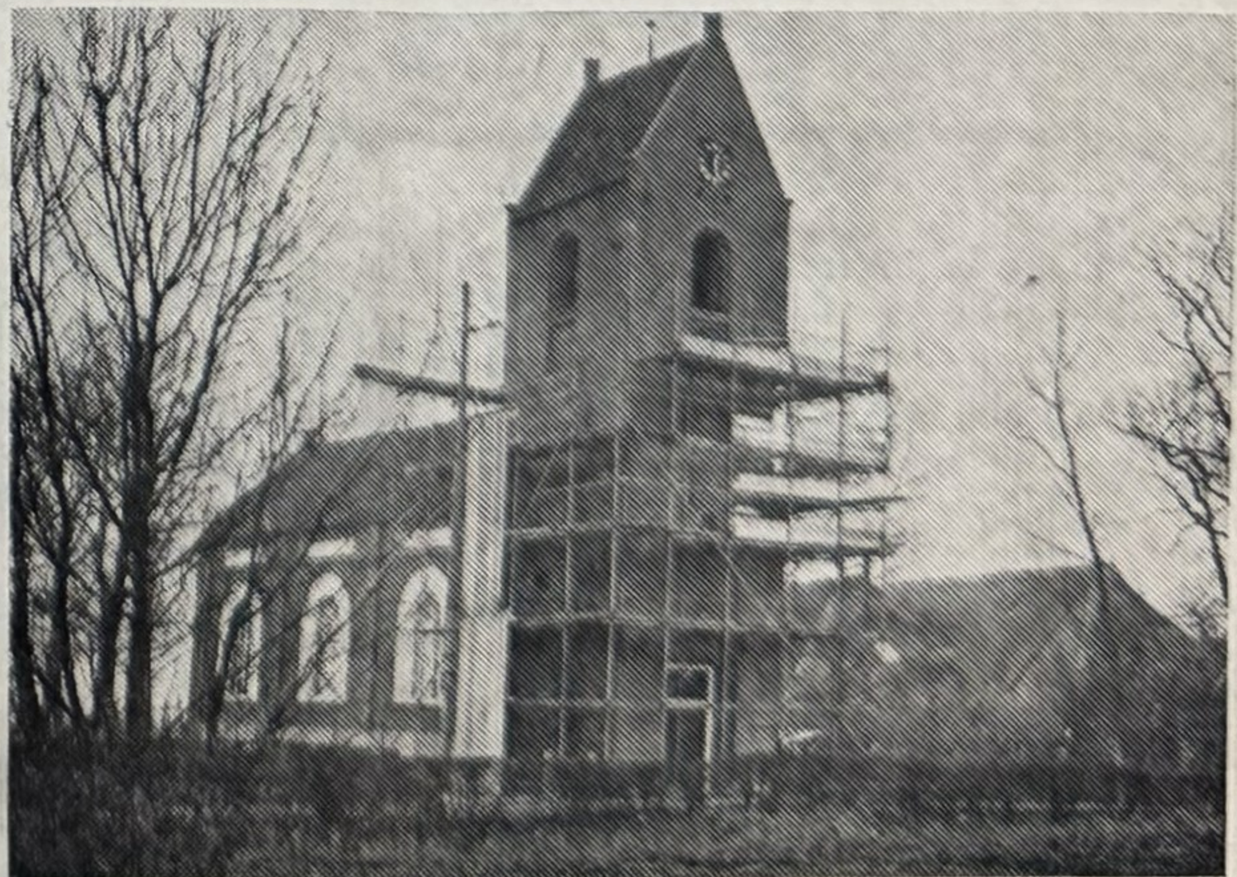
De toren van het kerkje te Saaksum. De restauratie is gereedgekomen ondanks dat de steigers nog aanwezig zijn.
